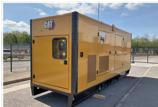
UNUSED - 2021 CAT DE550E0 550 kVA
